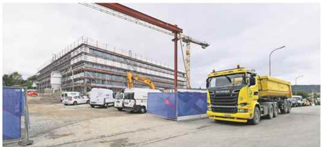
Die neue Sekundarschule an der Brillachstrasse in Laufen ist derzeit die grösste Baustelle, die der Kanton Baselland verantwortet.
